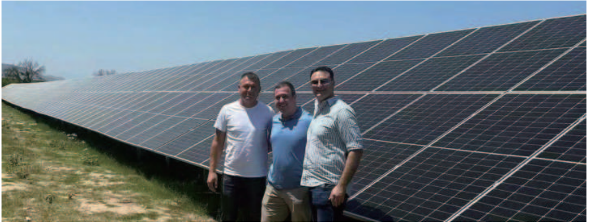
20MW 地面电站项目
